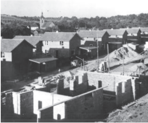
Die Doppelhäuser der Hettinger Siedlung „Neue Heimat“ im Bau, 1947
